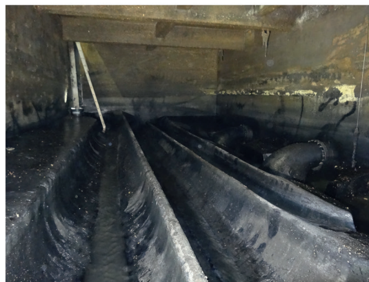
Figuur 1. Slingergoot in rioolgemaal Holwinde (Rotterdam). Links: 3D-overzicht van het ontvangstbassin. Rechts: foto van de slingergoot met aan de rechterzijde de zuigmonden. De slingergoot transporteert de vaste delen naar de zuigmond van de pomp. De hoge stroomsnelheden in de goot ontstaan door een vrije uitstroming vanuit de goot naar het verdiepte deel met de zuigmonden.
