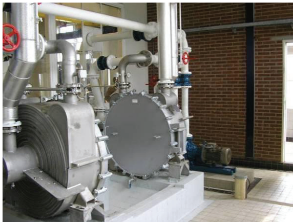
FIGUUR 5.8 EXTERNE SLIBVERWARMING DOOR MIDDEL VAN RONDE PLATEN [5]
